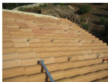
επανατοποθέτηση κεραμιδιών
