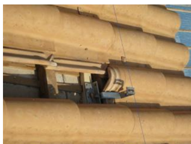
τοποθέτηση βάσεων στήριξης (τύπου hook)
