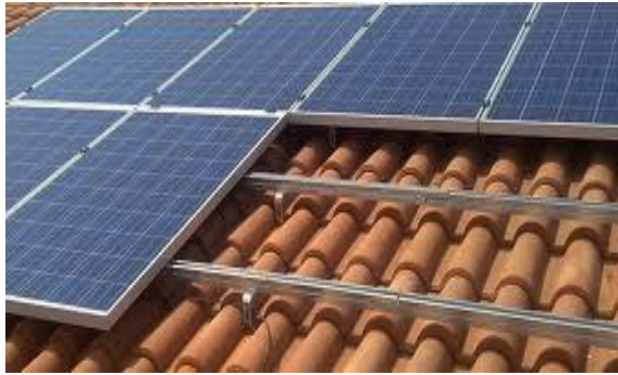
τοποθέτηση φωτοβολταϊκών πλαισίων
